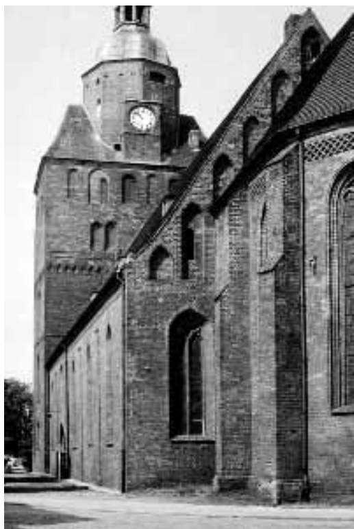
Zdjęcie 3. Gorzów, katedra, widok od południowego-wschodu (fot. J.Jarzewicz)
