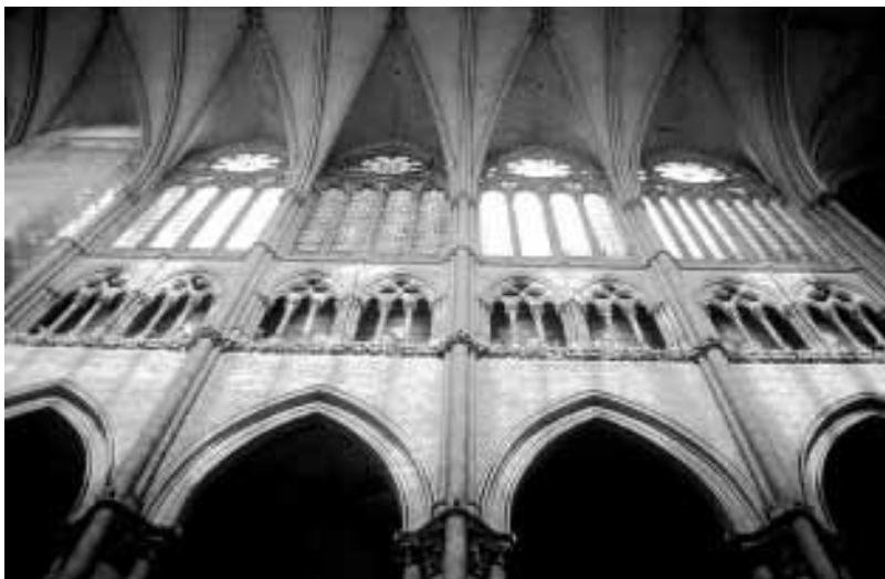
Zdjęcie 2. Amiens, katedra, północna ściana nawy głównej (fot. J.Jarzewicz)
