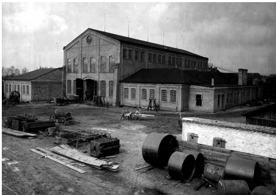
Widok na halę produkcyjną / Ansicht Werkhallen
