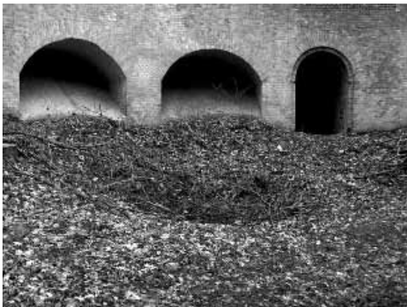
Foto 6: Luki opróżnione muru przeciwstoku; obok wejście do poterny prowadzącej do niższego poziomu baterii skrzydłowej
