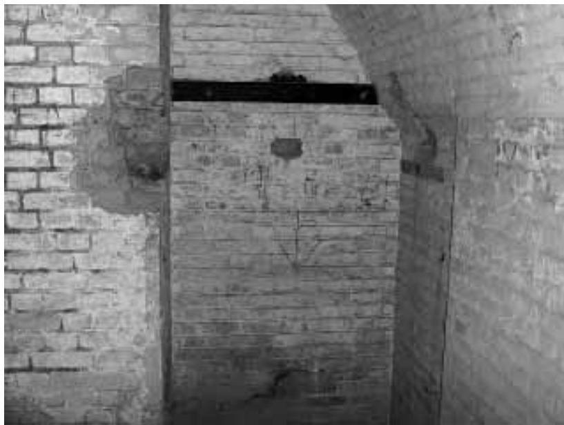
Foto 19: Górny fragment szybu windy amunicyjnej w schronie pogotowia artylerii
