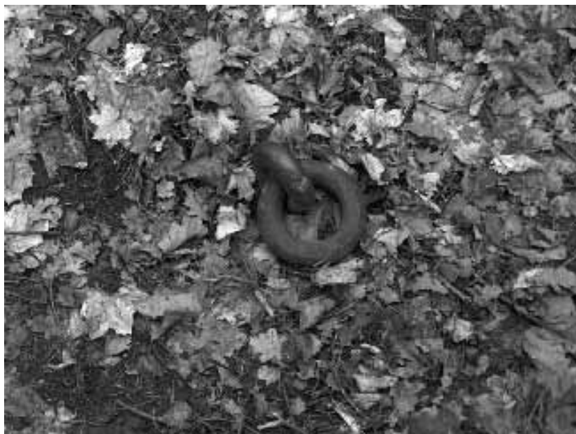
Foto 17: Masywne ogniwo zakotwione w nasypie rampy. Mocowano tu wielokrążek do wciągania armat na ławę działową
