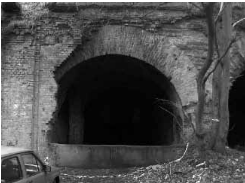
Foto 10: Wejście do poterny centralnej
