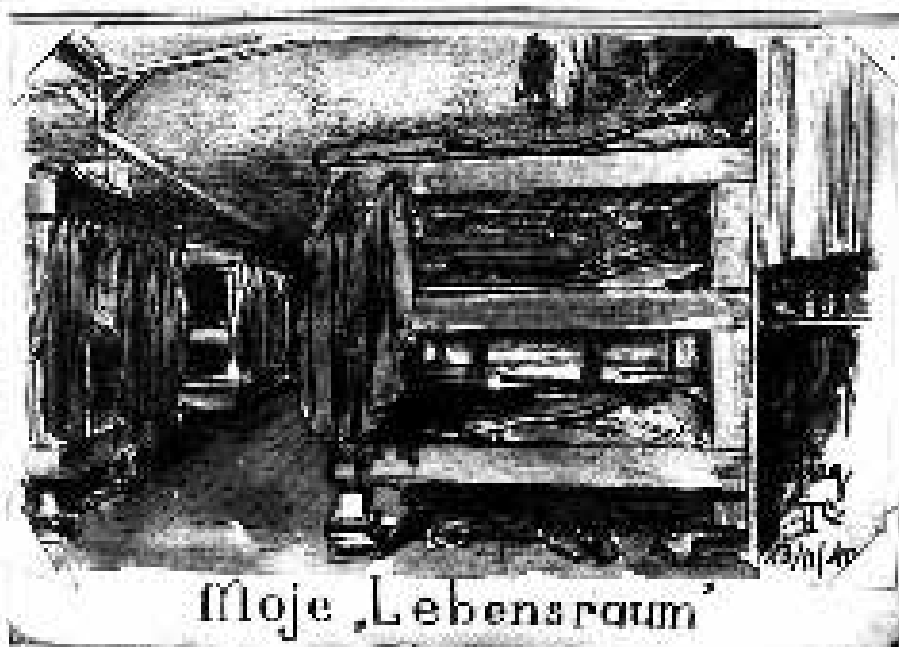
Fot. 9 Wnętrze izby mieszkalnej w baraku
